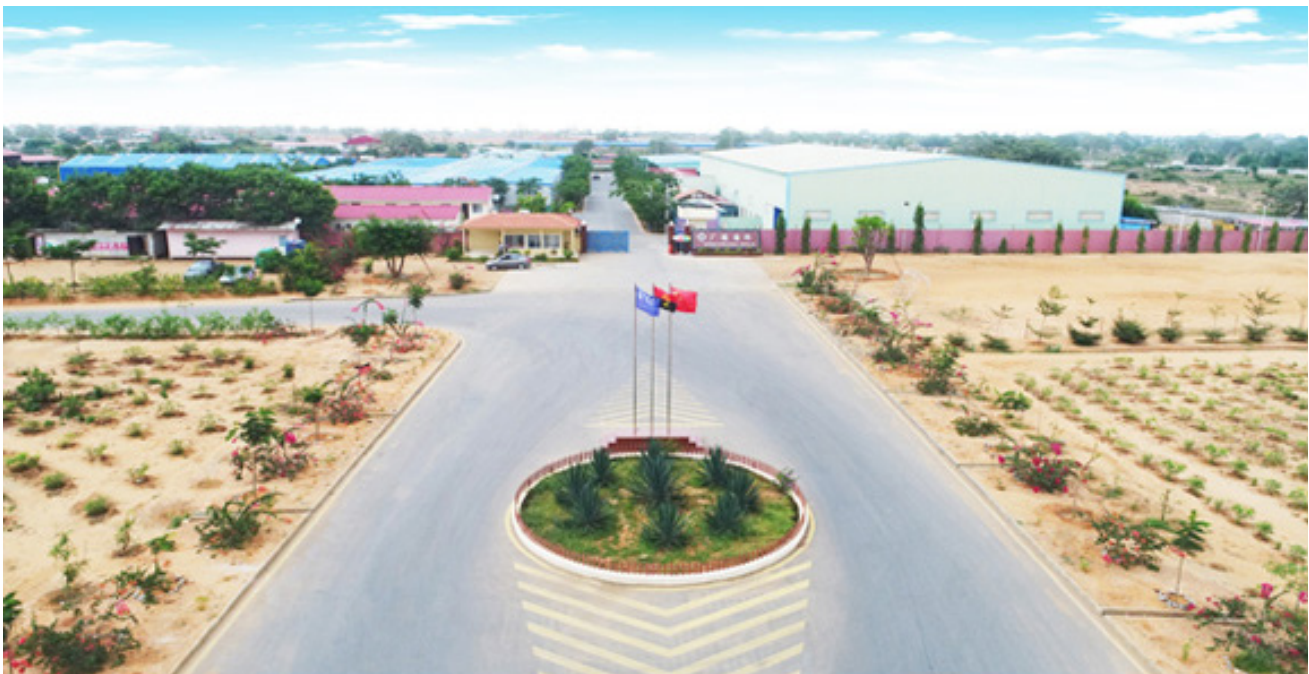
Figure 19 Parc industriel de Guangde en Angola
