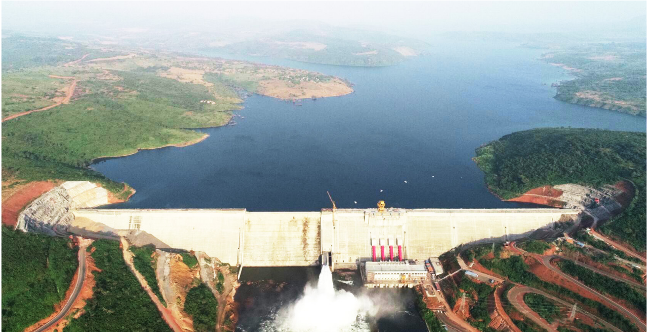
Figure 13 Le complexe hydroélectrique de Souapiti en Guinée
